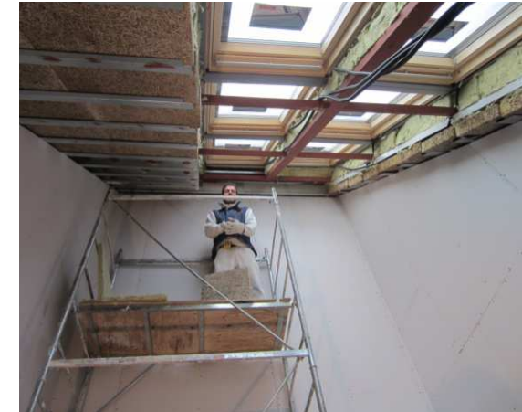
Iper-isolamento in poliuretano, polistirene, in lana minerale e lana di legno
